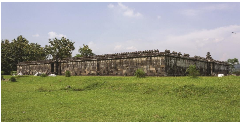
Caras norte y oeste de la pared prākāra alrededor de la estructura de doble plataforma, Ratu Boko, Java Central. © Crisco 1492, Wikimedia Commons
